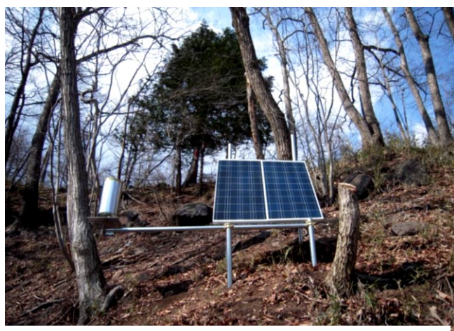
土壌流出観測システム 土壌中の水分量等の監視、地滑りの予測
