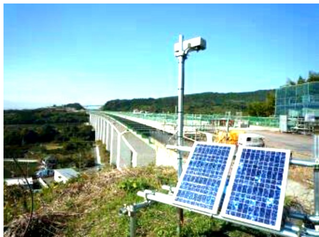
道路視程観測システム 高速道路の視程距離の観測
